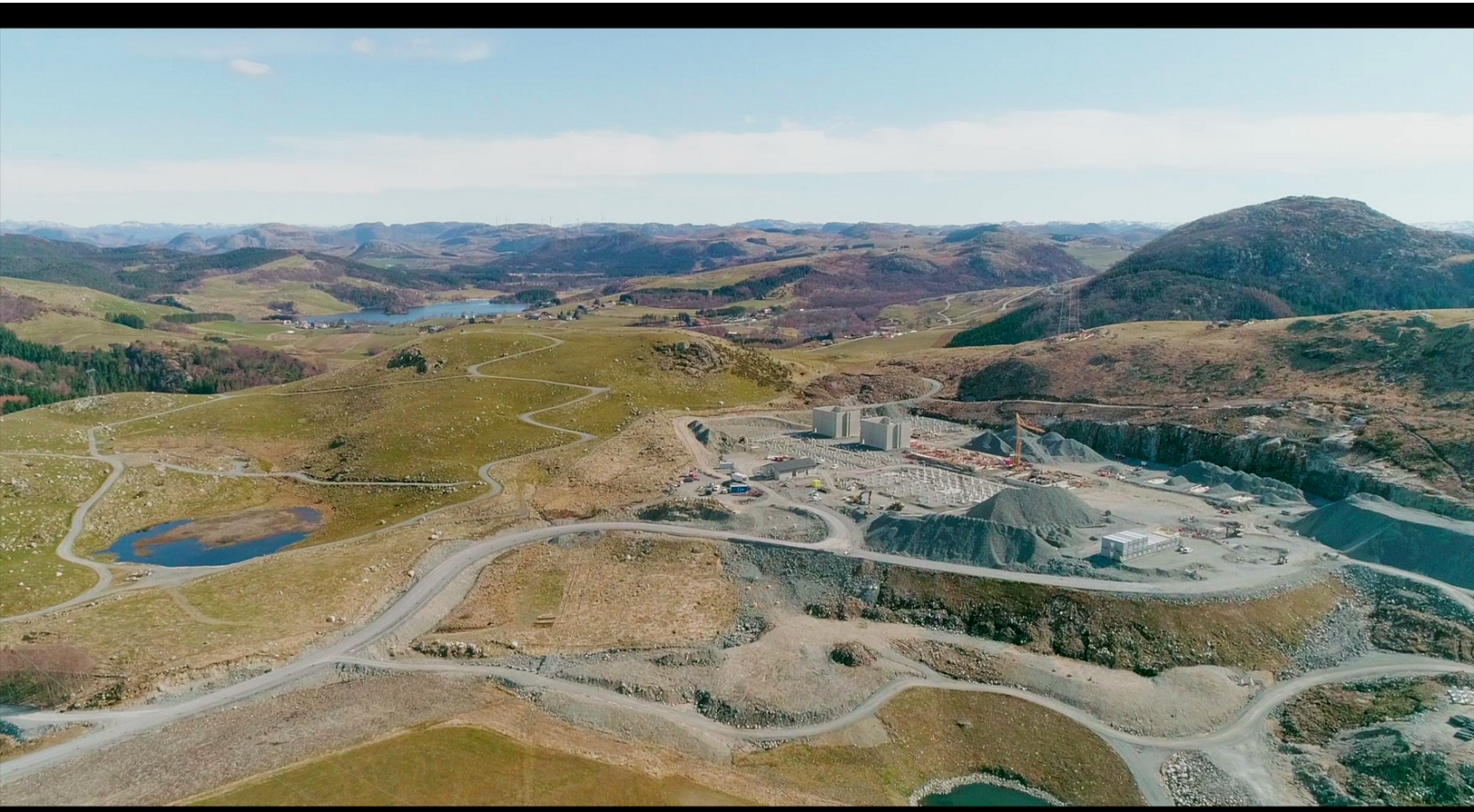
Byggingen av Fagrafjell Trafostasjon på Kalberg
